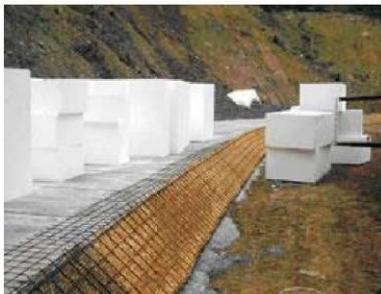
In opera i blocchi di EPS, posti su più strati, vengono collegati interponendo tra questi appositi tasselli dentati in metallo (gripper) che permettono la trasmissione delle tensioni tra loro e ne favoriscono il fissaggio durante le operazioni di cantiere.
