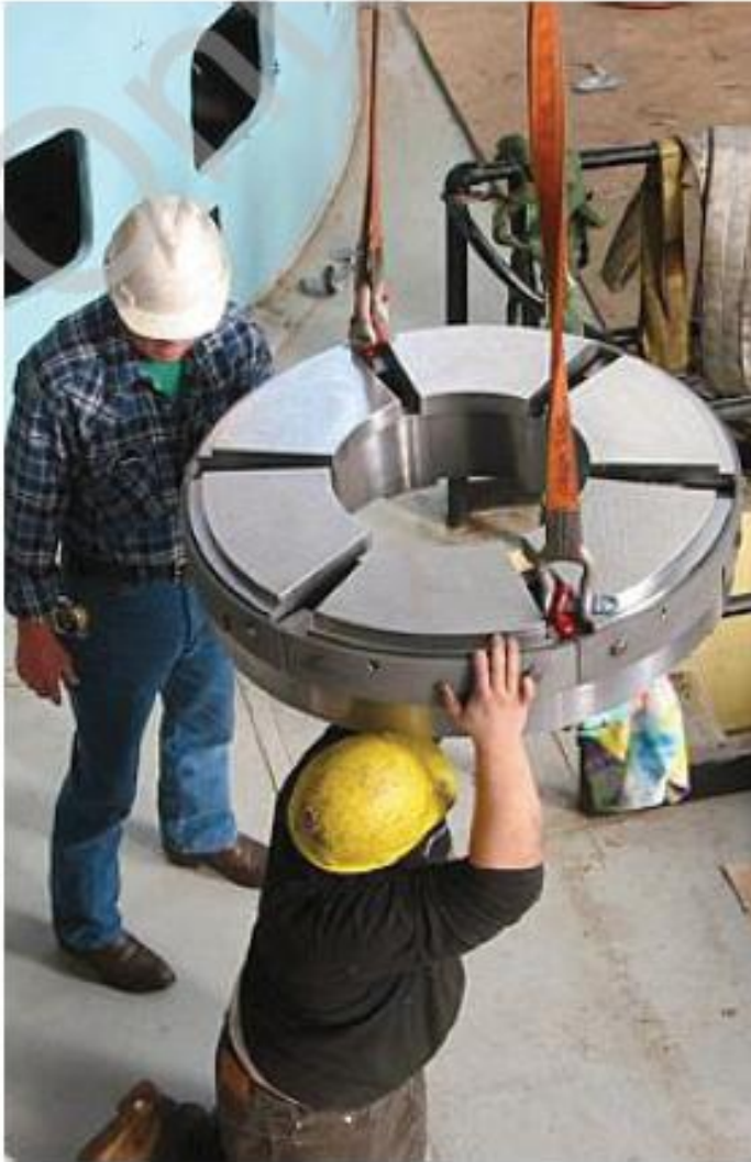
Cuscinetto reggispinta a pattini fissi fluidodinamico
